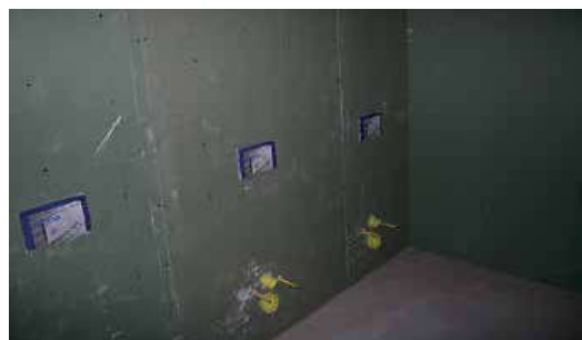
Nieuwe toiletruimten zijn gecreëerd.
