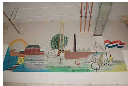
Een wandtekening uit 1961 wordt zoveel mogelijk gespaard, maar ontkomt niet aan de nieuwe installatietechniek.
